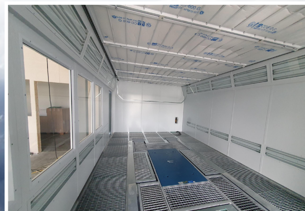
Skolans nya lackbox under uppbyggnad. Se fler bilder på bolest.se
